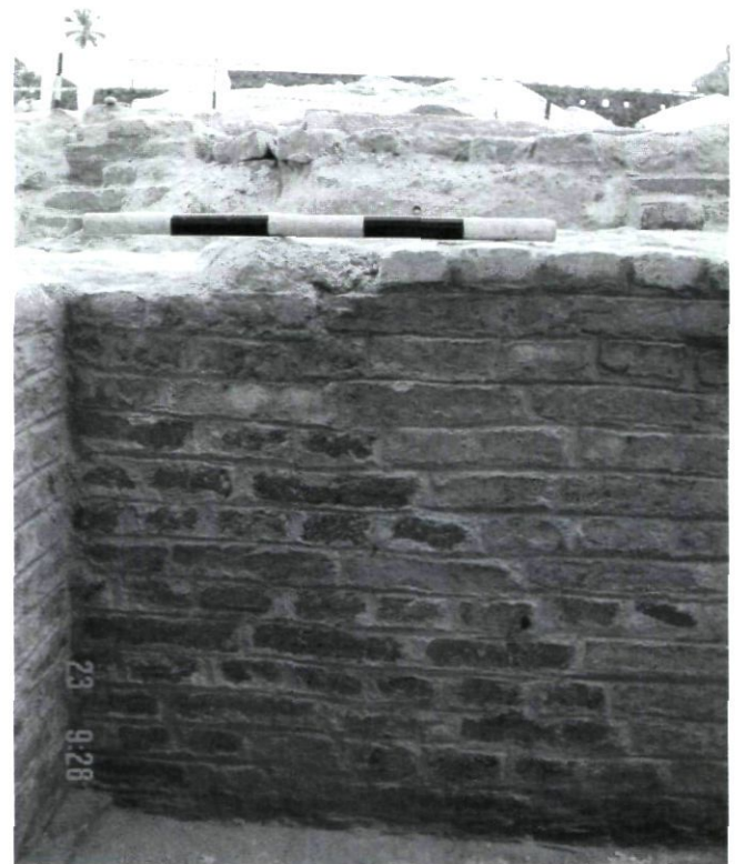
Afb. 10. Nederlandse bakstenen in het muurwerk van de kruitkamer, Fort Oranje, Itamaracá, PE. Foto: O.F. Hefting 2002.
