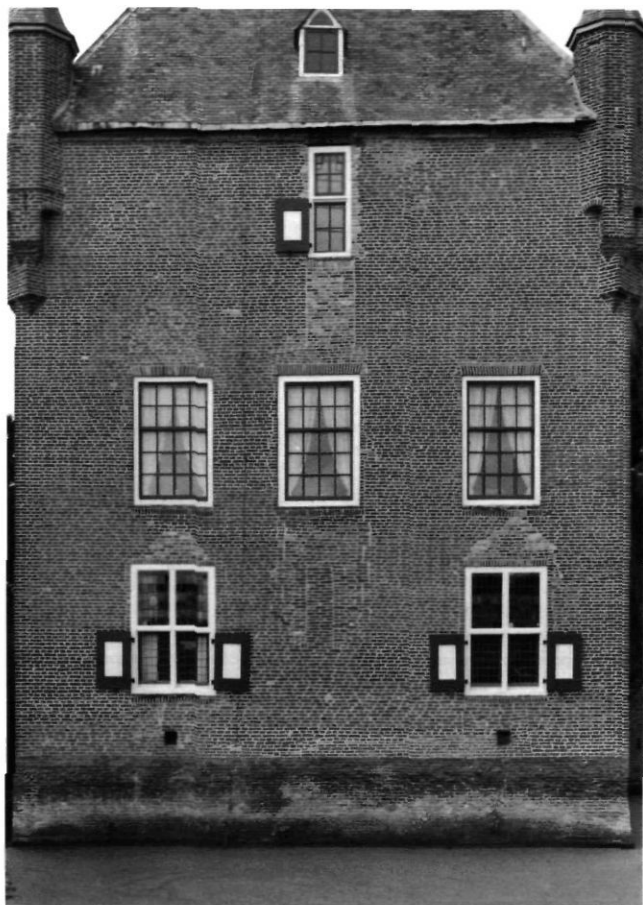
Afb. 11. De oostgevel van de woontoren
