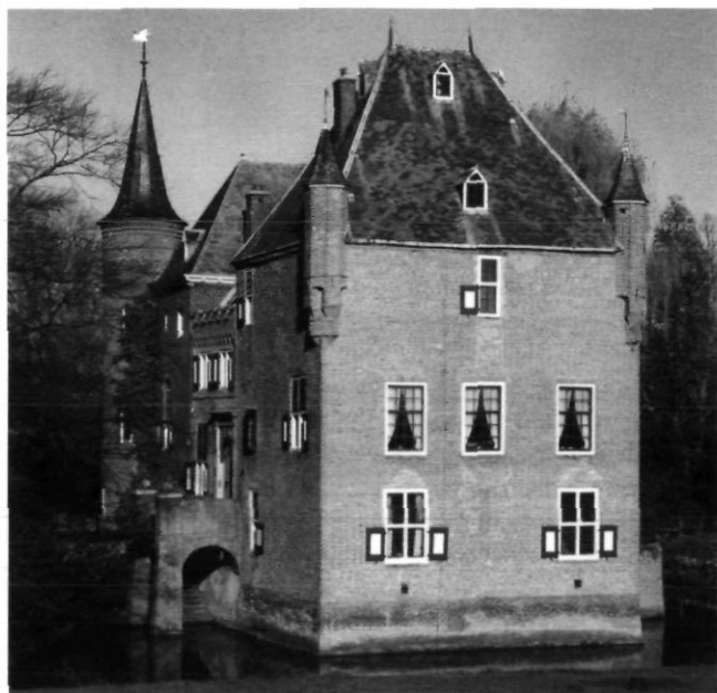
Afb.1. Slot Well vanuit het zuidoosten
