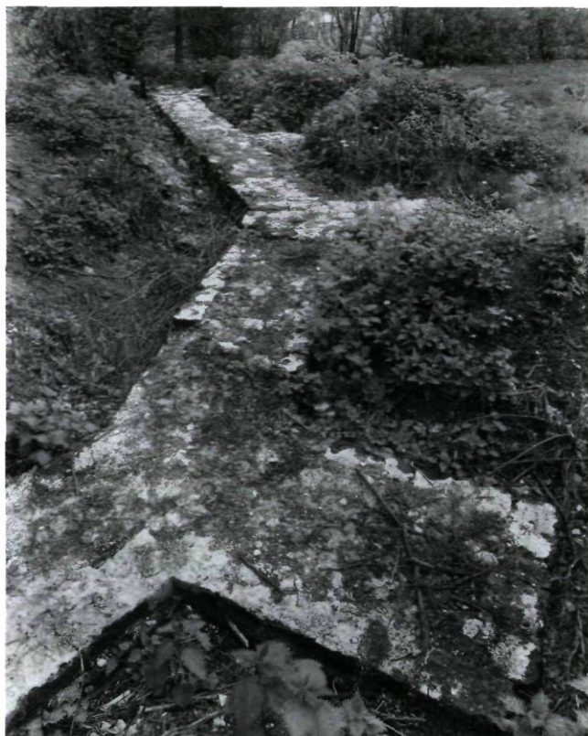
Afb. 8. Fundering N. Muur en sluiting koor (foto G. Dukker, RDMZ 1969).
