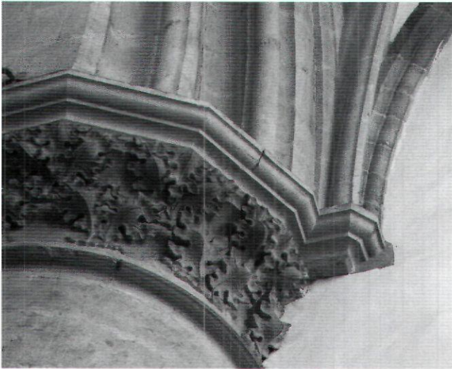
Afb. 16. Haarlem, Sint-Bavokerk, kapiteel tegen de westwand van het schip, Evert Spoorwater/Jan Trappaert, 1462 (foto auteur)
