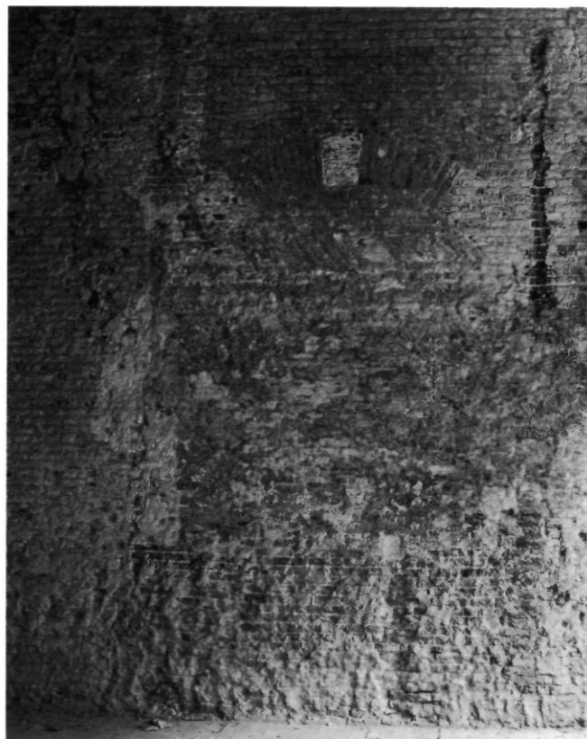
Afb. 1. Amsterdam, het v.m. Oost-Indisch huis, Oude Hoogstraat 24. Restanten van de vensters van het v.m. Bushuis (foto G. Dukker RDMZ 1978).
