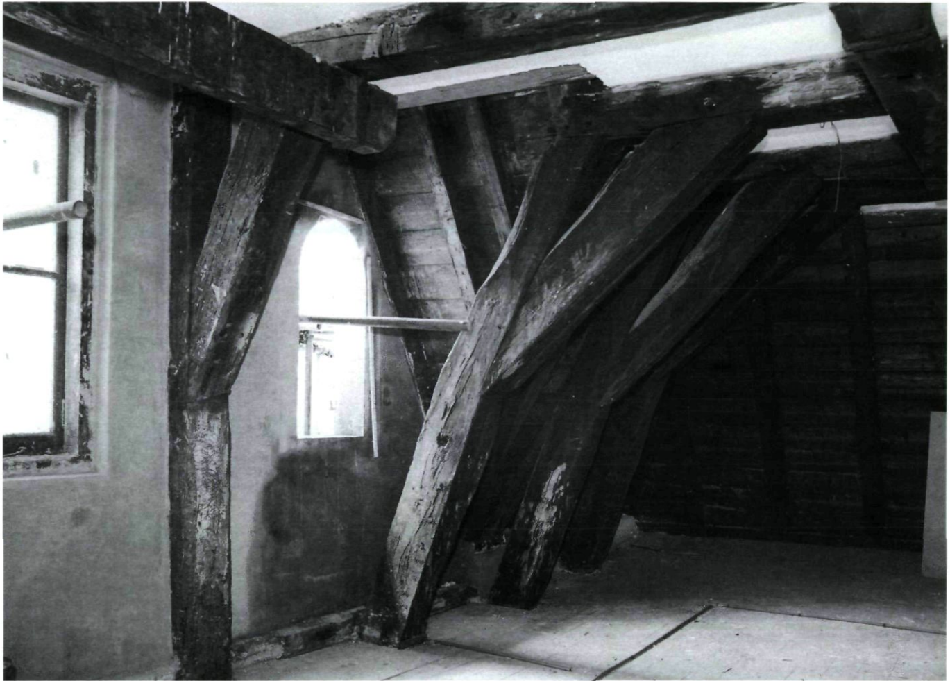
Afb. 9. Amsterdam, het v.m. Oost-Indisch huis, Oude Hoogstraat 24. Een gedeelte van de kapconstructie van de zuidvleugel met de muurstijlen van de topgevel aan de binnenplaats (foto G. Dukker RDMZ 1978).
