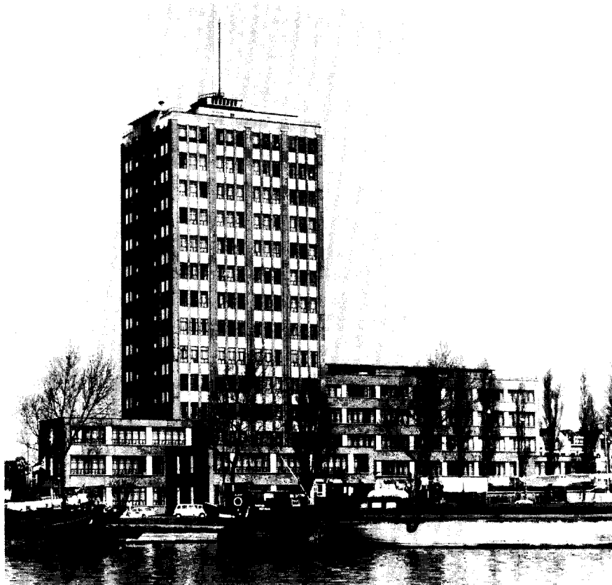
Afb. 7. Het G.E.B.-gebouw te Rotterdam (foto: archief G.E.B., z.j.).
