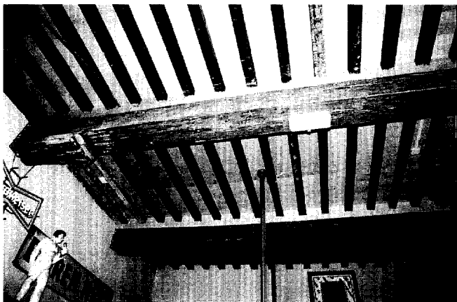
Afb. 4. Het herstelde moer- en kinderbintenplafond. Helaas is op een onbewaakte moment het 'spreidseel' vastgeschroefd op de kinderbinten, voordat de kopschotjes tussen de moerbinten waren geplaatst. De aftimmerplank langs de moerbint is daar de stille getuigenis van (foto auteur).
