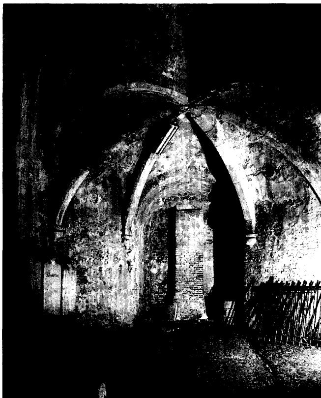
Afb. 4. De gewelfde hal van het bastion met de dichtgemetselde toegang. Vanuit deze ruimte gaan drie hellende gangen naar de verschillende kanonkamers (foto Gemeentelijke Fotodienst Utrecht).
