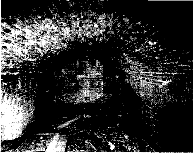
Afb. 7. Een van de kanonkamers in bastion Zonnenburg Utrecht is ten dele dicht gestort. In de kopwand zijn de bogen, een kijkgat en een schietgat zichtbaar (foto Gemeentelijke Fotodienst Utrecht).
