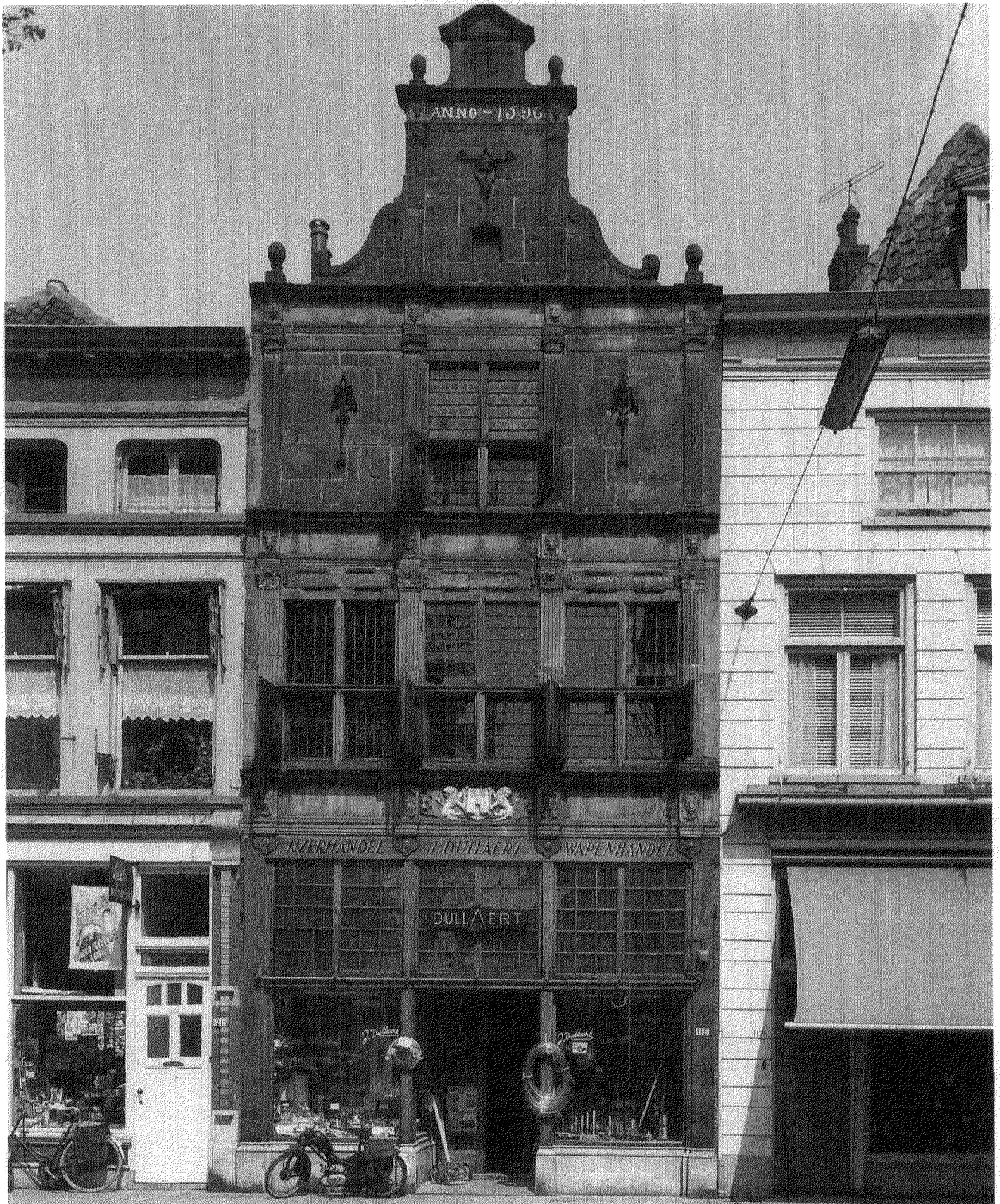
Afb. 2. Kampen, het Oude Vleeshuis, Oudestraat 119, na restauratie in 1939 (foto Rijksdienst voor de Monumentenzorg, Zeist, 1960).
