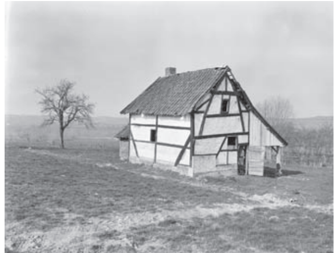
Afb. 19. Limburgs bakhuisje in vakwerk aan de Bommerigeweg in Helle (Rijksdienst voor het Cultureel Erfgoed, 1967)
