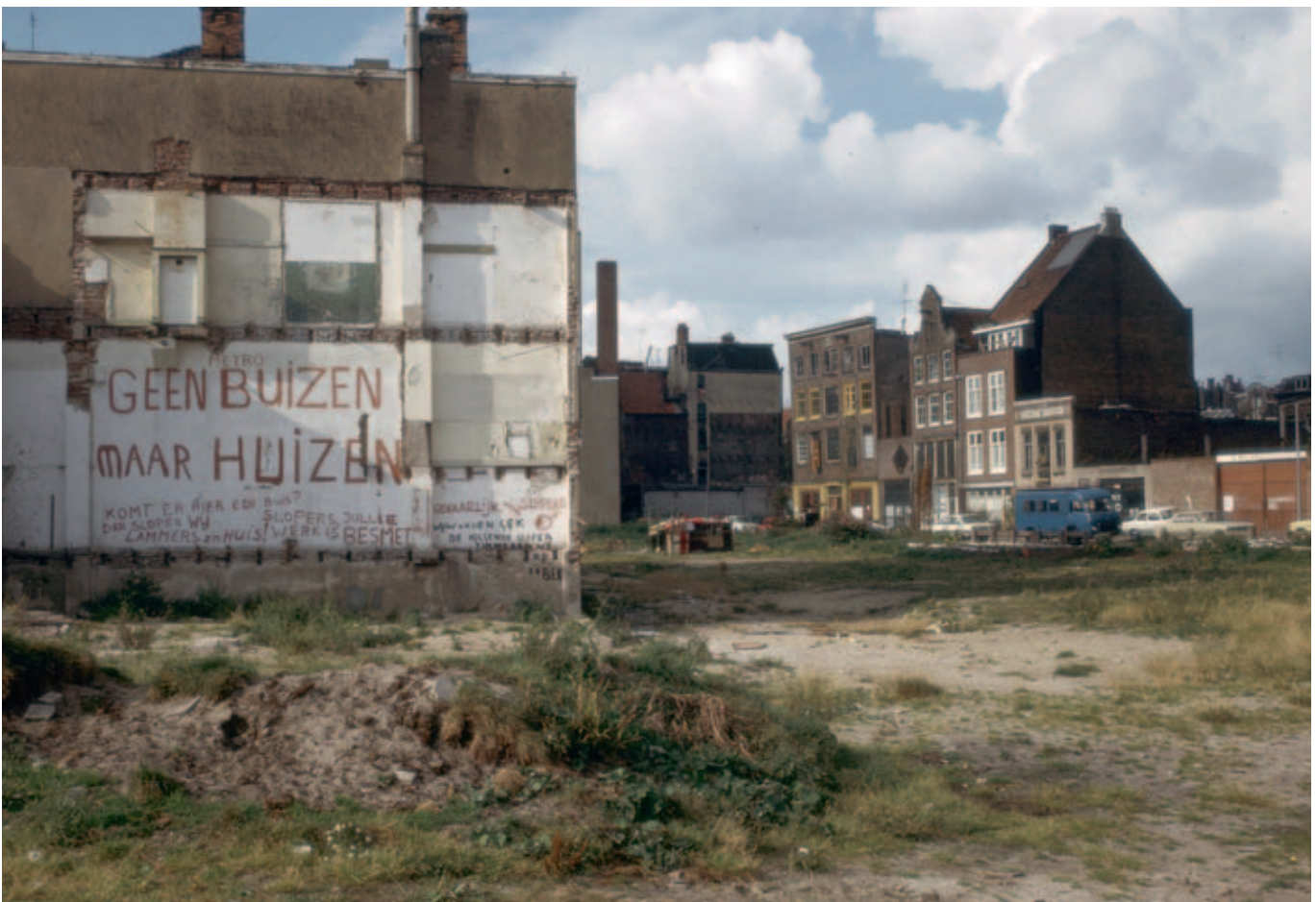
Afb. 7. Nieuwmarktbuurt in Amsterdam tijdens de aanleg van de metro, met protestteksten op de resterende huizen, 1974 (Rijksdienst voor het Cultureel Erfgoed)
