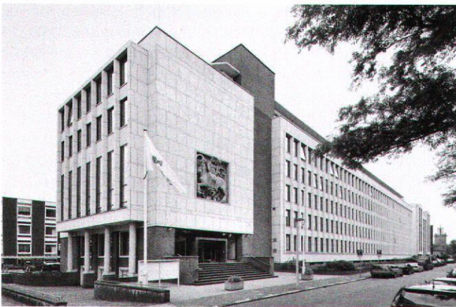
Afb. 10. Den Haag, kantoor van het Hoofdproductschap voor Akkerbouwproducten aan het Stadhoudersplantsoen van J.W.E. Buijs, J.B. Lürsen en W. Verschoor, 1955; het gelijktijdig gebouwde buurpand voor de Administratie van het Nederlands Rundveestamboek is inmiddels door een nieuw kantoor vervangen.
