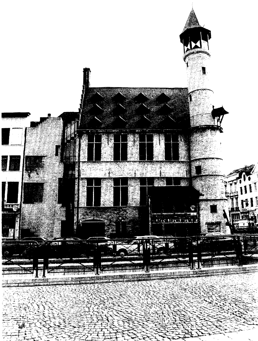
3. Het voormalige gildehuis van de huidenvetters, 'Het Toreken', aan de Vrijdagmarkt, na de restauratie en de toevoeging van hedendaagse integratie-architectuur (foto Stad Gent, D.M.S.A.).
