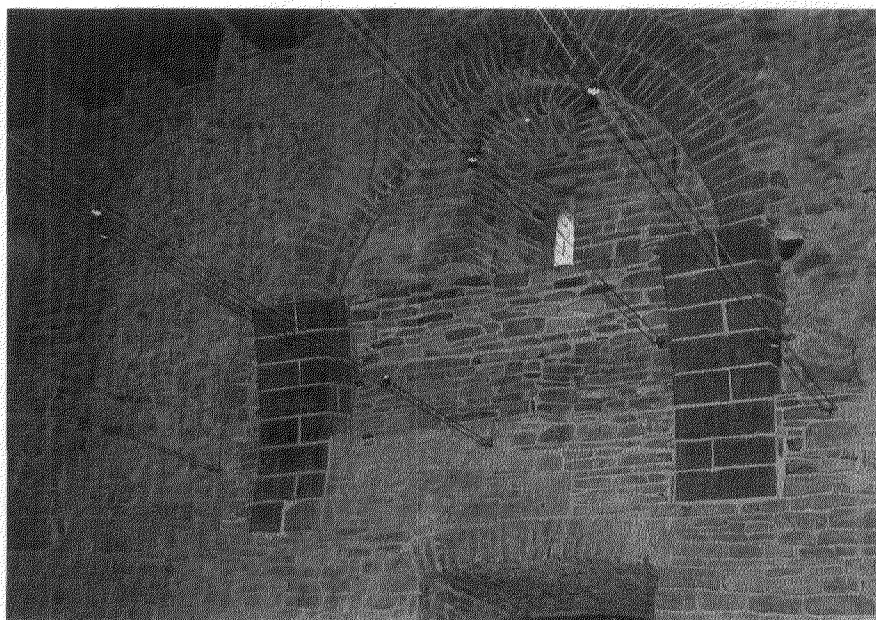
5. Gerestaureerde boogaanzet aan de oostelijke langsegevel van de donjon in het Gravensteen (foto Stad Gent, D.M.S.A.)
