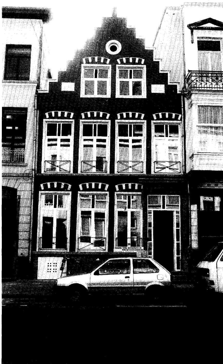
1. De gerestaureerde gevel van Kammerstraat 10 (foto Stad Gent, D.M.S.A.).
