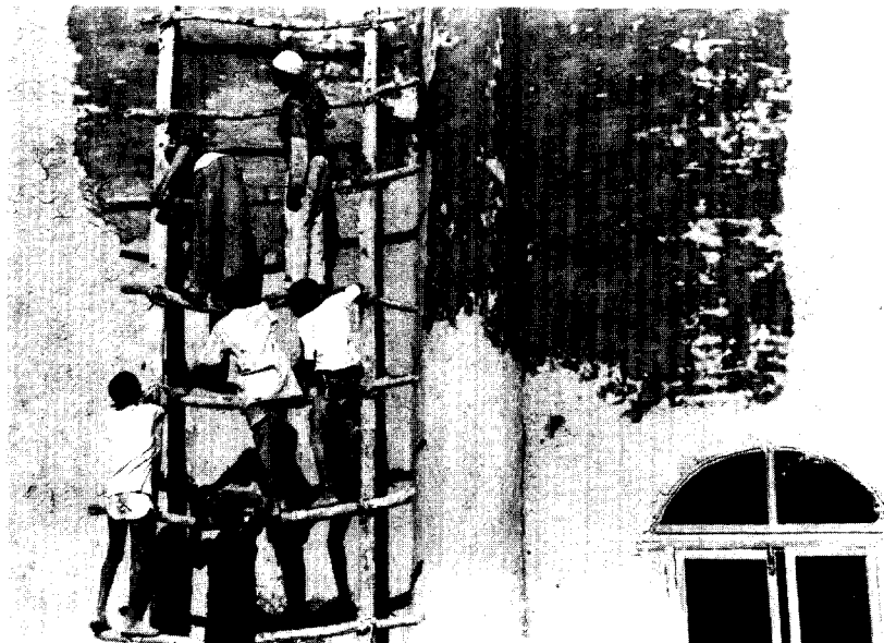
Afb. 10. Het bepleisteren van de Grote Moskee, 1988.
