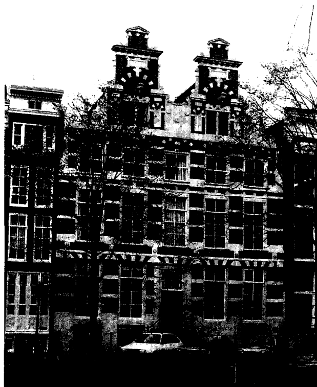
Afb. 17. Singel 140-142, huis De Dolfijn van Laurens Jansz Spiegel (tussen 1599 en 1603). Ontwerp De Keyser. Rechthoekig middendeel top. Vredeman de Vries-details: muurnissen in top en gekoppelde boogjes, strekken boven verdiepingvensters in de horizontale lijst erboven. Beeldhouwerk in top door hijsbalk verdenen. Foto RDMZ. (G. Dukker, 1987).
