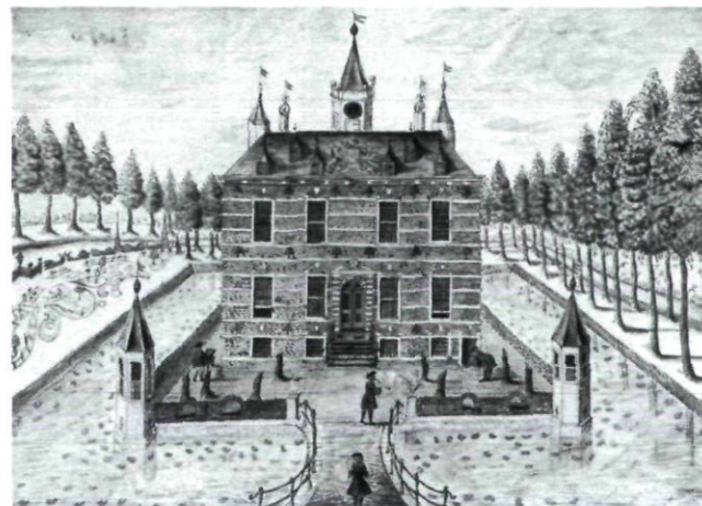
Afb.16. Capelle II. Voorplein van hoog standpunt gezien. Opzetstuk boven gootlijst. Nieuwe brug en verlaagde ommuring. Bovendeel bomen weggedacht. Toegang onderhuis rechts (I. Kortebrant, 1737. GAR; RISCH 97-15)
