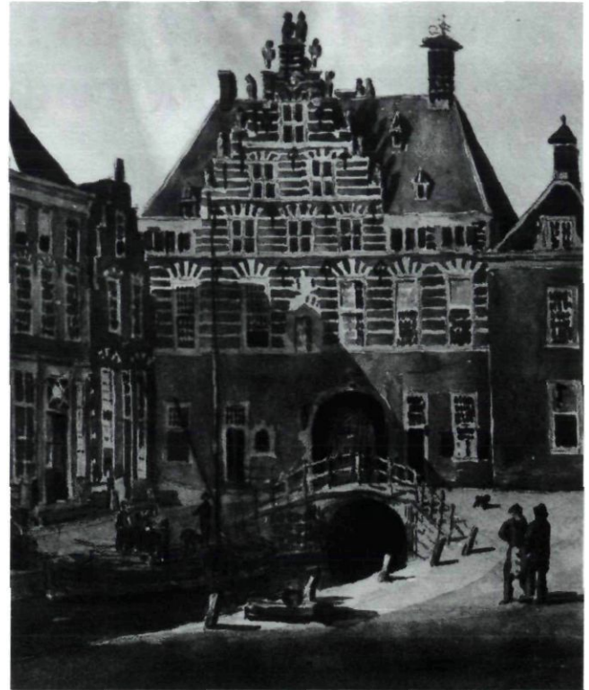
Afb.2. Delft, Waterslootse Poort, stadszijde, voor de sloop in 1846. Nieuw bovenstuk (1593) op beschadigde stadspoort. Pronkdak met siertop en schoorstenen op nokpunten, de linker vernieuwd (foto RDMZ)
