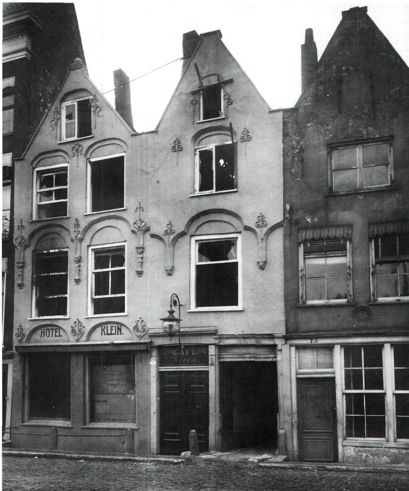
Afb. 13a. Rotterdam Haringvliet 77,75,73 uit 1592. 'Delftse' gevelbogen (GAR)
