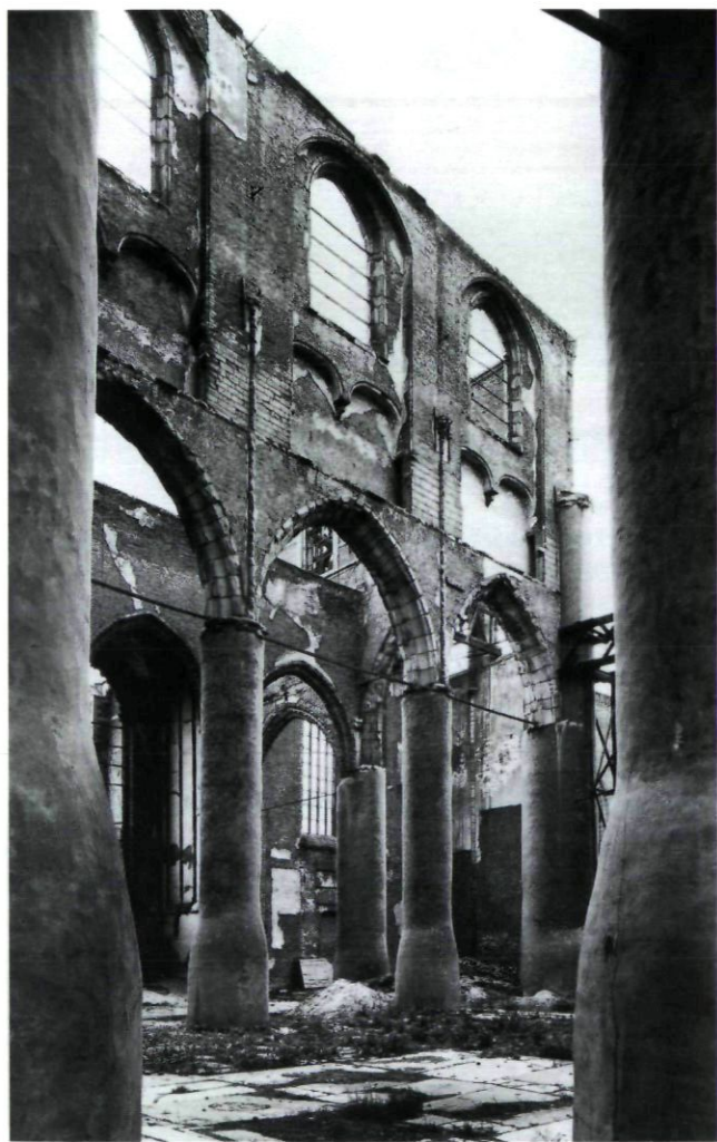
Afb. 8. Zuidwand hoogkoor (RDMZ 1950). Stenen skelet van pijlers en muurdammen, met loopgang van natuursteen. Dun muurwerk en vensters in de bovenste bogen. Op achtergrond zijkapellen en dwarschip.
