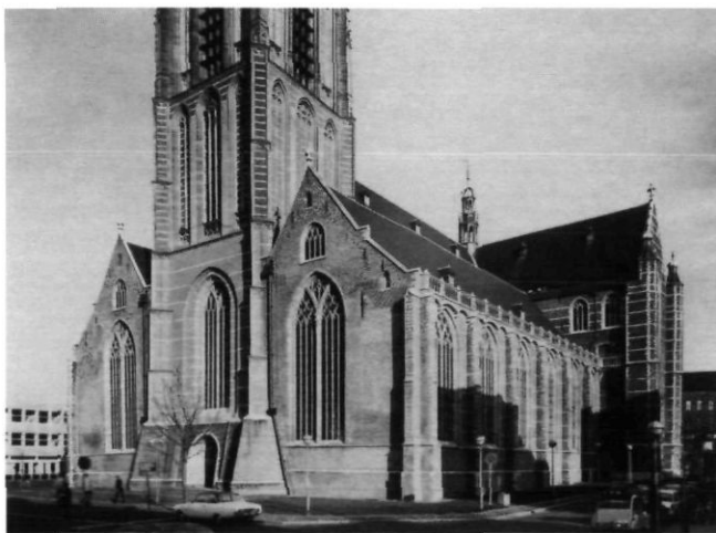
Afb. 4. Zuidwestkant (RDMZ 1970). Onderstuk toren 1449, tweede en derde geleding 1547, verzwaarde voet 1651. Westgevel zijbeuk 1461, zuidgevel herbouwd 1512. Zichtbare deel dwarsschip, 1500.
