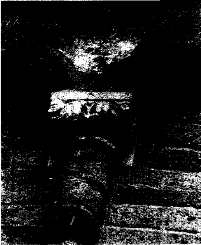
Afb. 12 De vensterzone van de absiswand. Korfkapiteel met blad- en maskerversiering ten noorden van het middenvenster (foto auteur 1997).
