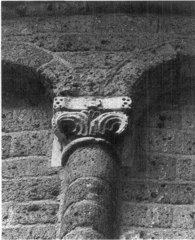
Afb. 10 De vensterzone van de absiswand. Het tweede bladkapiteel uit het zuiden met antikiserende abacus (foto auteur 1997).
