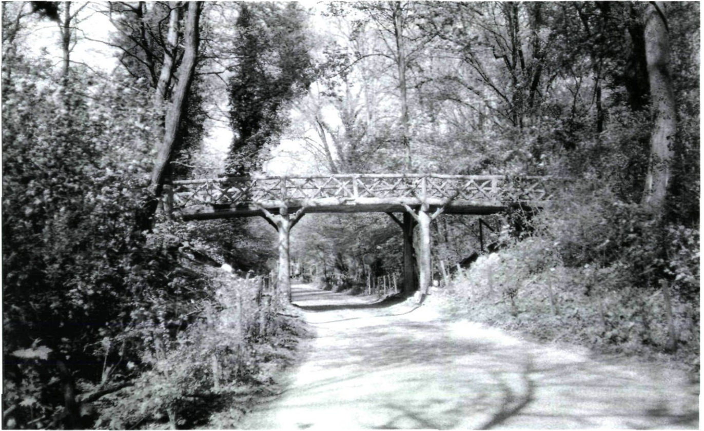
Afb. 1. De oorspronkelijke cementrustieke brug door de firma Moerkoert bij kasteel De Haar.
