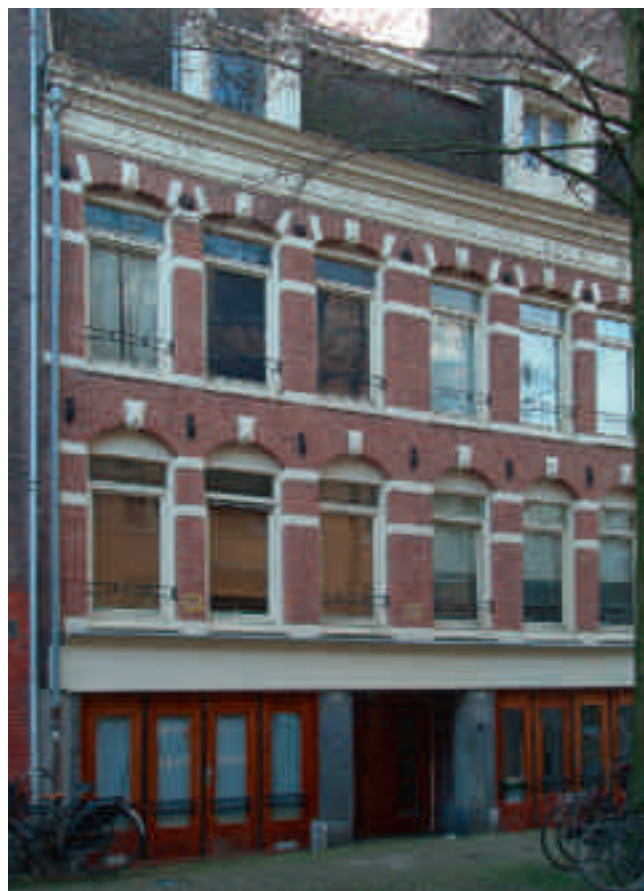
Afb. 9. Van Ostadestraat 298-300 (1892). De lage beganeg grondverdieping van deze huizen is het gevolg van het ophogen van de straat omstreeks 1907 (David Mulder)
