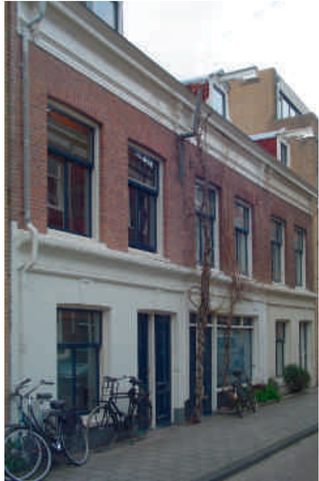
Afb. 4a. Kleinschalige bebouwing aan de Rustenburgerstraat 78-82 uit de periode voor de annexatie van Nieuwer-Amstel door Amsterdam (David Mulder)
