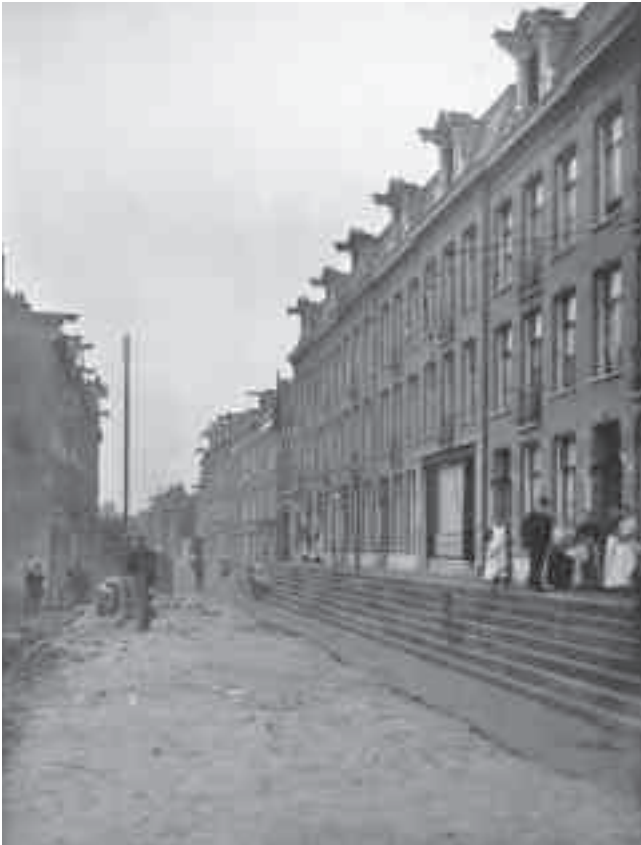
Afb. 5. Niveaunderschillen in de Kuipersstraat, 1910. Links Nieuwer-Amstelse bebouwing op polderpeil, rechts nieuwe huizen op stadspeil, gebouwd na de annexatie van 1896 (Gemeentelijke Dienst Volkshuisvesting, Stadsarchief Amsterdam)
