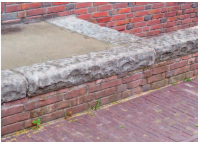
Afb. 1. Overzicht van station Naarden-Bussem, met onder detail van afdekkanten uit Doornikse kalksteen (foto's augustus 2007)
