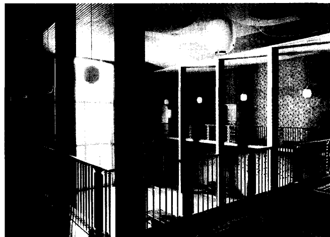
Afb. 3. Centrale hal van het voormalig ministeriegebouw van OK&W, kort na oplevering. Foto: Van Ojen 1953.
