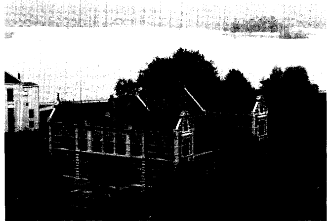
Afb. 4. Tiel, voormalig 'Regtsgebouw', nu Kantongerecht en huisvesting rijksdiensten. Ontwerp J.F. Metzelaar 1878; oplevering 1882. Foto Oerlemans-Van Reeken 1996.
