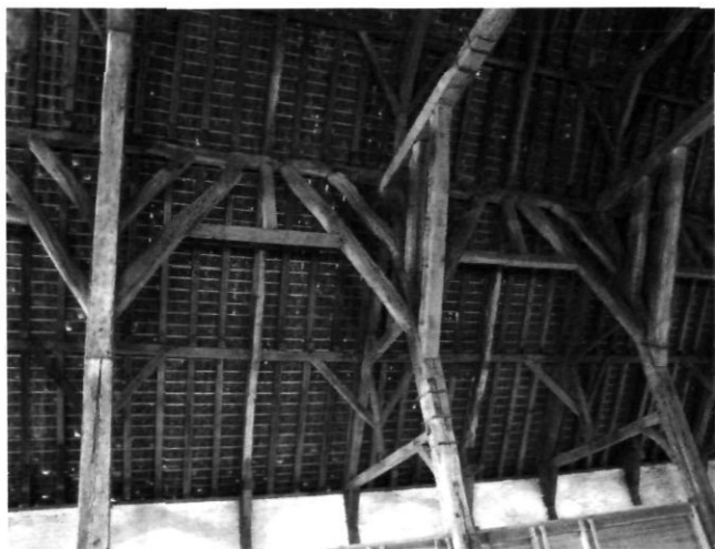
Afb. 6. Zicht op de langse versterking tussen de hoofdgebinten, toestand na de restauratie (foto D. Nuytten, 2004)
