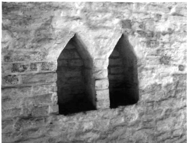
Afb. 11. Dubbele lamnissen in de oostelijke langsgewel (binnenzijde) (foto D. Nuytten, 2004)
