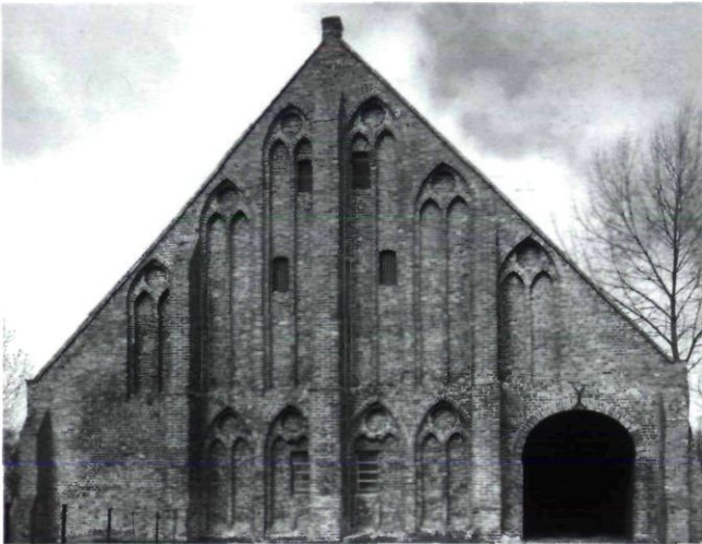
Afb. 14. Bestaande poortopening in het rechter deel van de zuidelijke kopgevel van Ter Doest (foto D. Nuytten, 2002)
