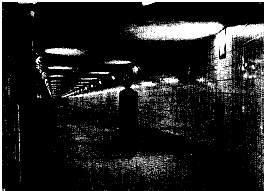
Maastunnel Rotterdam, voetgangerstunnel (ca. 1955, ansichtkaart uitg. van Diltmar's Couranten Import en Kioskenonderneming n.v.).
