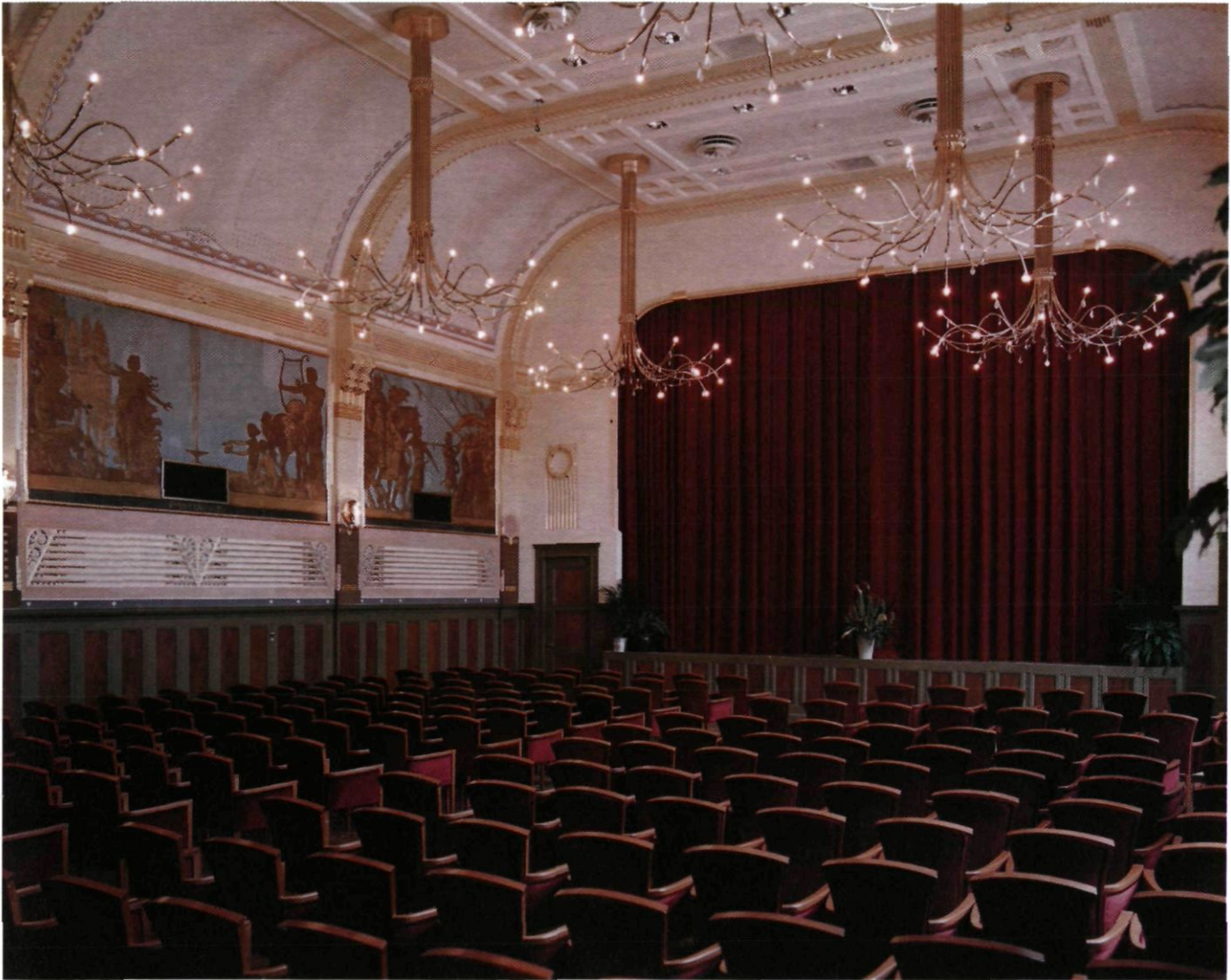
Afb. 13. De Kleine Zaal voltooid in een samenspel van verschillende benaderingen. In de gerestaureerde schilderijen blijven de ontbrekende delen zichtbaar. De geschilderde vlakornamenten, de ontbrekende consoles en de podiumwand zijn geheel gereconstrueerd naar het oorspronkelijke voorbeeld. De verlichting is een product van renovatie (foto Anita Pantus 2000)
