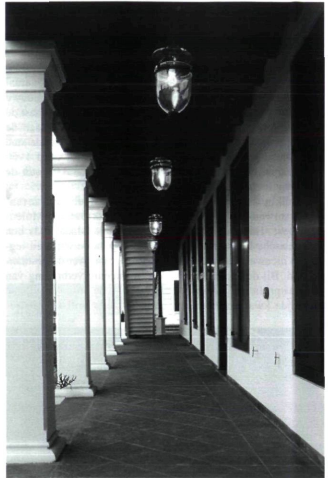
Afb. 10. Zijvleugel op het achterterrein (zie afb. 9) na restauratie (foto Cor Passchier)
