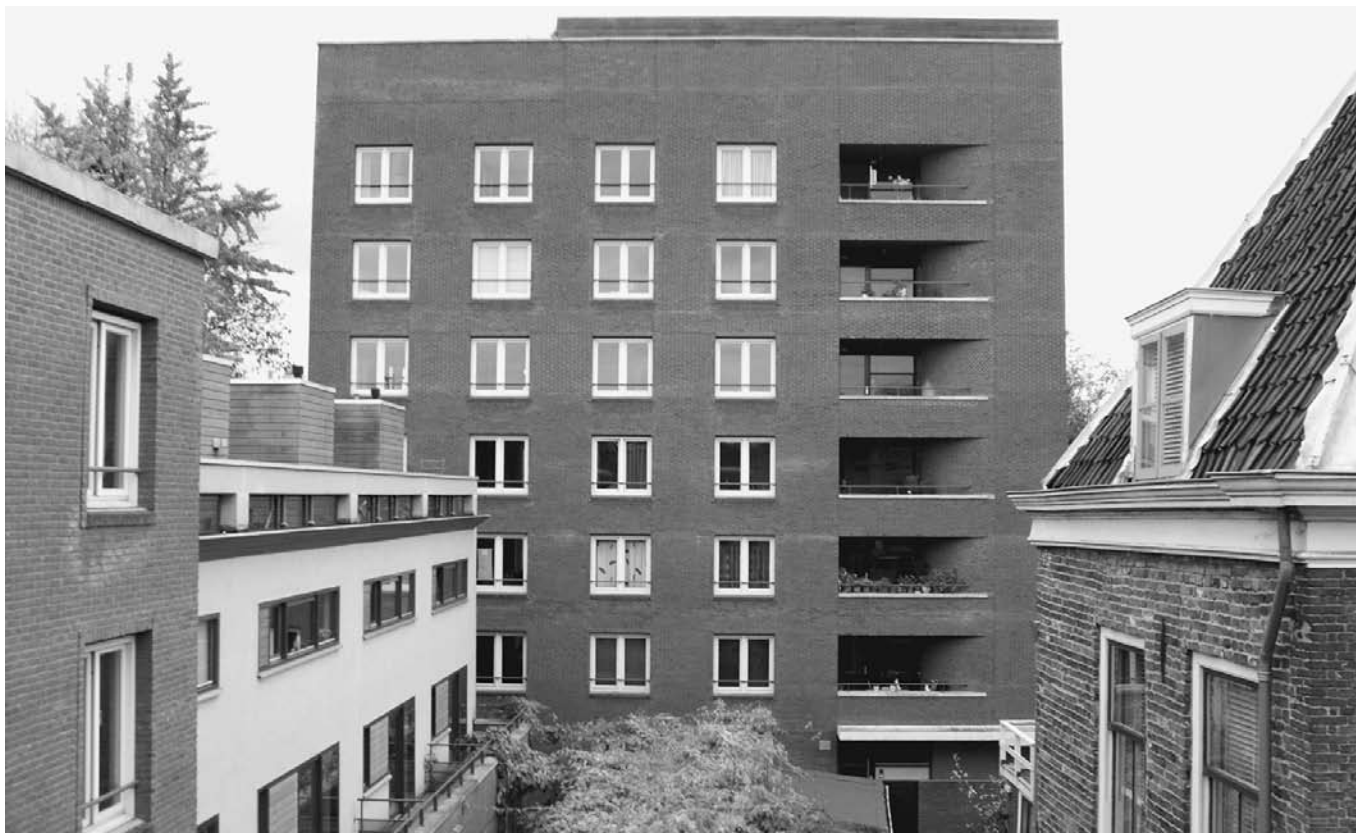
Afb. 12. Utrecht, Hof van Sint Jan, woontoren vanuit de Boothstraat, rechts op de voorgrond de zijgevel van het huis Boothstraat 6 (foto auteur, 2008)
