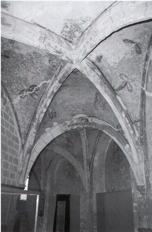
Afb. 10. Bij de herbouw van de kapel aan het einde van de veertiende eeuw werden nieuwe vormen toegepast. In de omgang werden aan de zuid- en oostzijde van de omgang op de begane grond kruisribgewelven aangebracht, die gedeeltelijk op geometrische, gedeeltelijk op figuurlijke consoles rusten.
