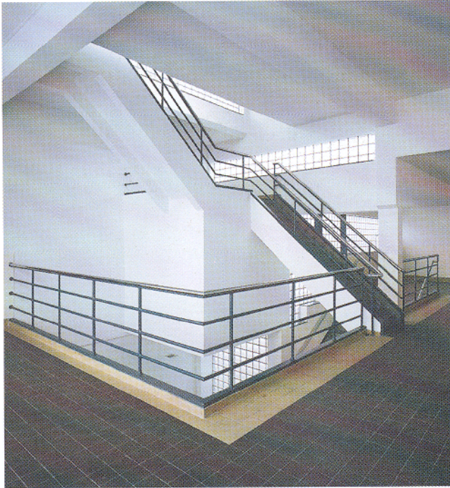
Afb. 3. De Derde Ambachtsschool na restauratie trappenhuis en gang, eerste verdieping (foto RDMZ 1999).
