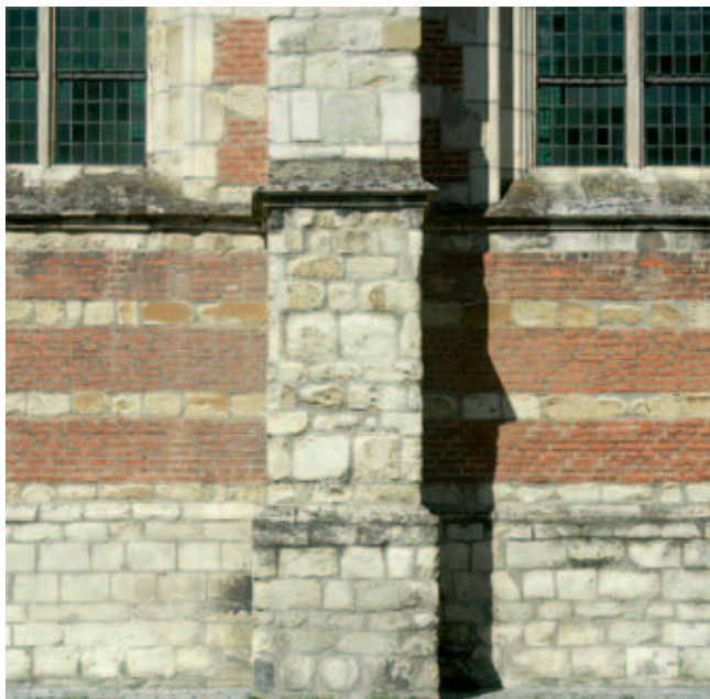
Afb. 13. Gevelvlak van de zuiderzijbeuk van de Maria-Magdalenerkerk te Goes (foto september 2009)
