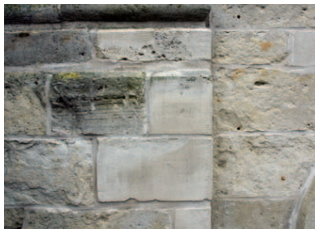
Afb. 17. Mortelreparatie met frijnslag aan de voet van de toren van de Sint Annakerk te Bottelare (België)
