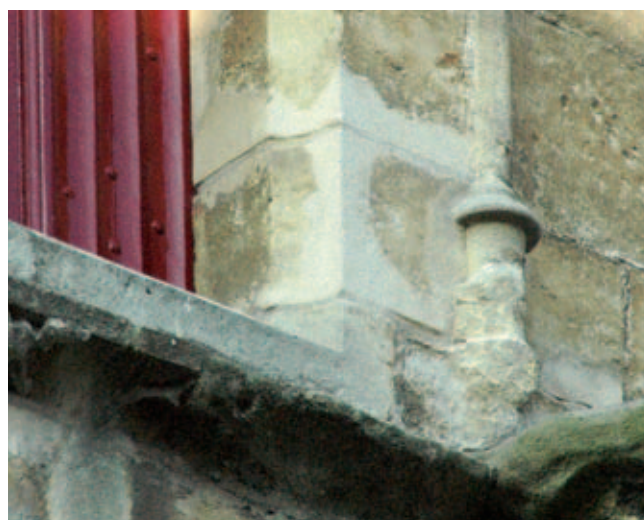
Afb. 16. Mortelreparatie (Jahnmortel) aan het Stadhuis te Tholen
