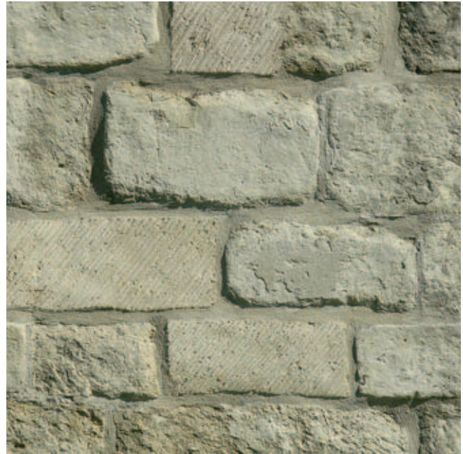
Afb. 11. Metselwerk in Ledeesteen, ontdaan van korsten, gerepareerd met mortel en opnieuw gevoegd. Steunbeer westgevel (foto september 2009)
