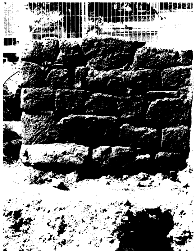
Afb. 11. Zuid-annex, zuidelijk deel oostwand vanuit oosten.
