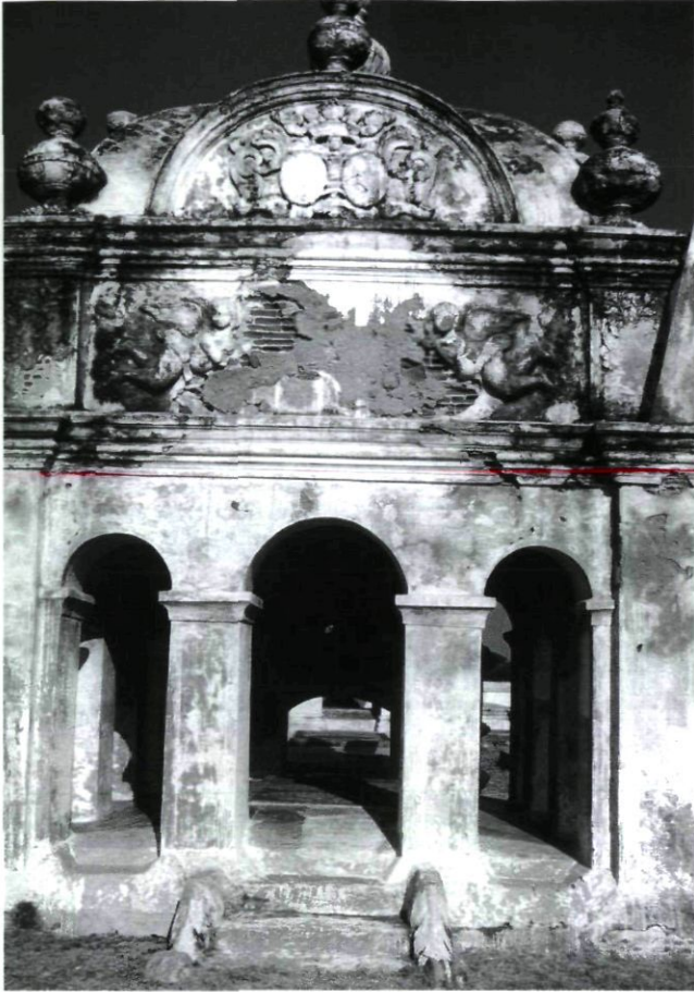
Afb. 13. Overkoepeld graf op het Binnenkerkhof, 1737; voortschrijdend verval (foto Hans Schiebroek)
