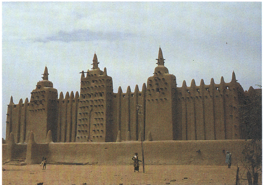
Afb. 3. De oostgevel van de grote moskee.
