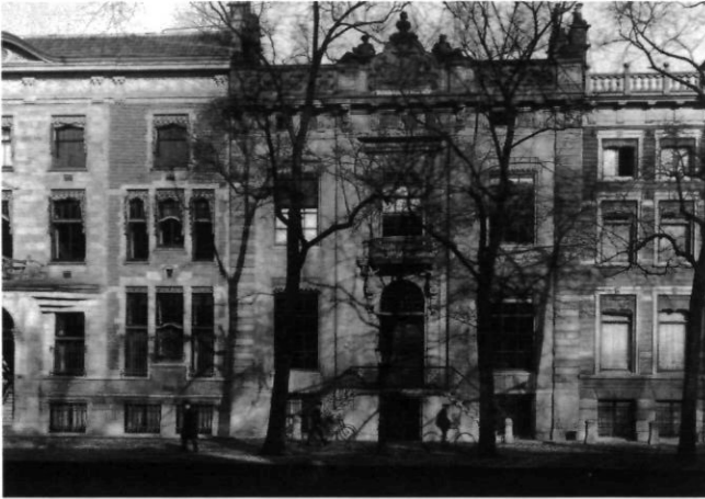
Afb. 13 Vooraanzicht van Herengracht 539 in 1915. Het pand heeft hier nog de negentiende-eeuwse vensters, die na de restauratie begin jaren zestig werden vervangen naar het voorbeeld van de tekening (Bureau Monumenten & Archeologie Amsterdam)
