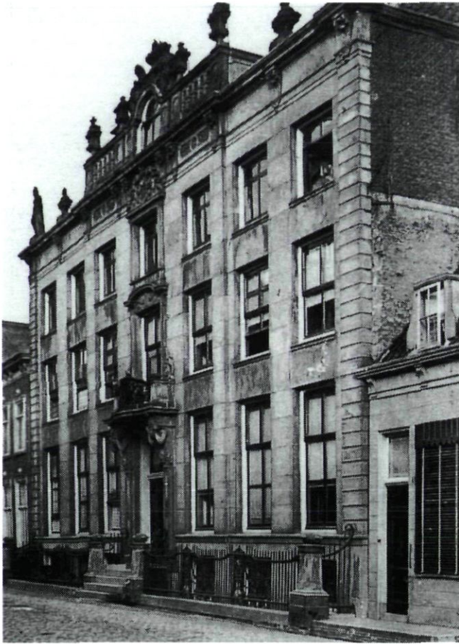
Afb. 18 Voorgevel van het huis aan de Grote Oost 43 te Hoorn, woonhuis van Nanning van Foreest. De natuurstenen gevel van 1724 werd voor drie bestaande huizen geplaatst (RDMZ)
