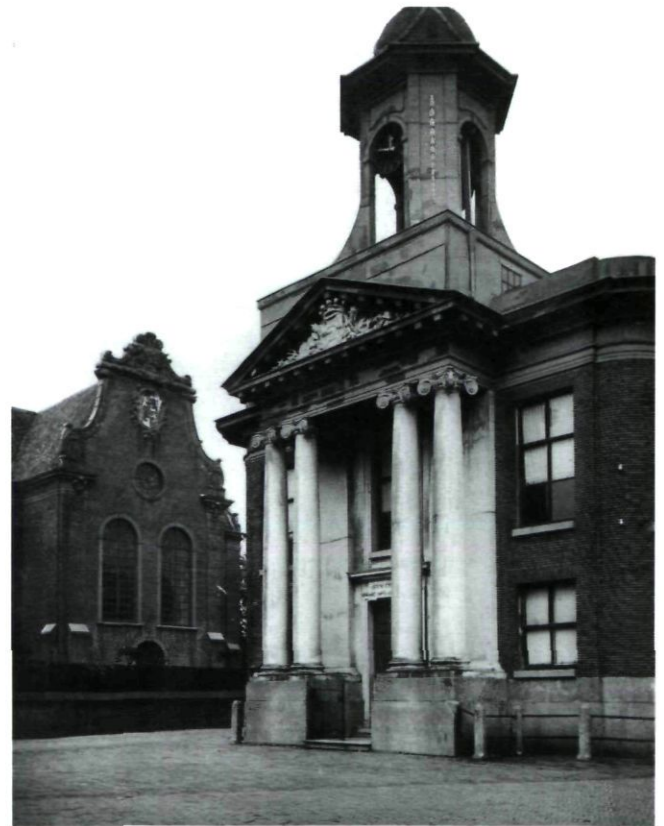
Afb. 11 Westzaan, Raadhuis uit 1781-1783 naar ontwerp van J.S. Creutz; links de Nederlands-Hervormde kerk van 1740-1741 (Rijksdienst voor de Monumentenzorg)
