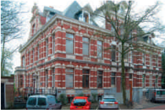
Afb. 7. Vondelstraat 81-85, R. Cruijff en H. Schouten, 1881 (Jos Smit, 2012)
