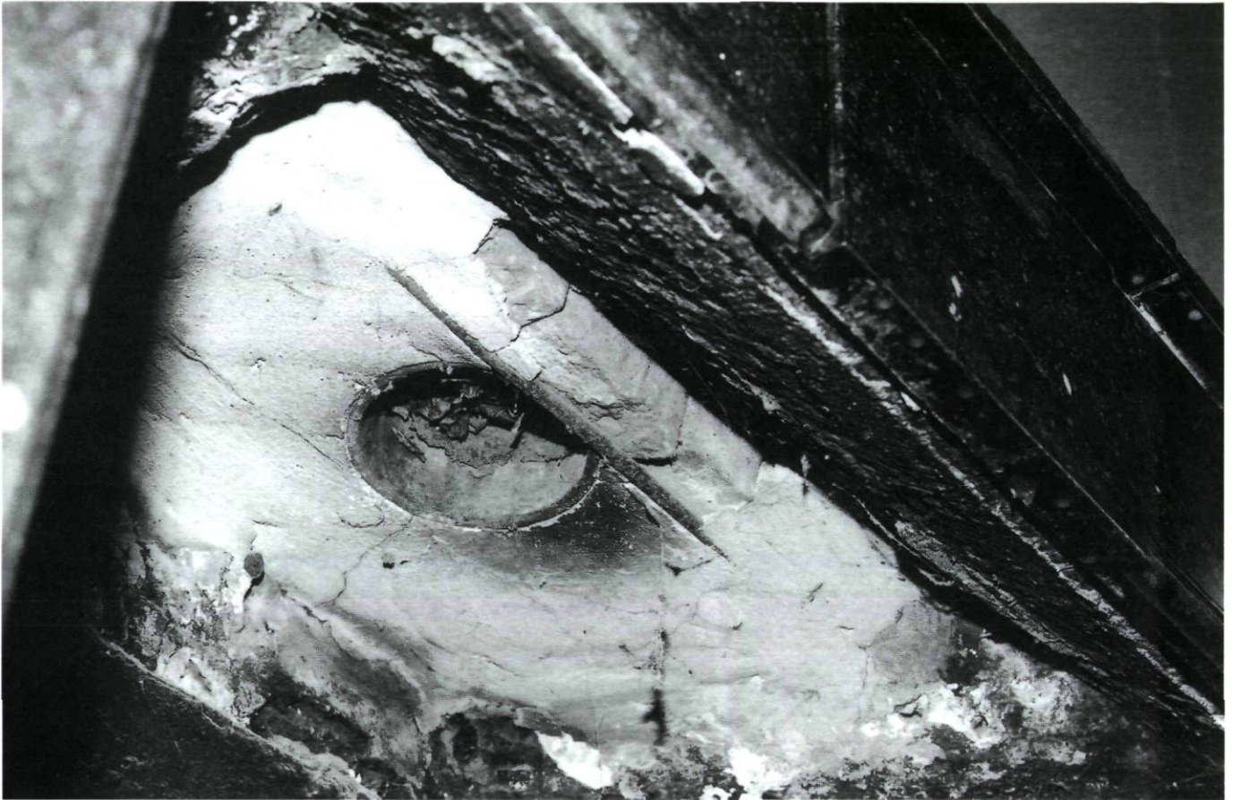
Afb. 2 Rookkanaal vanuit de stookplaats gezien (foto door M.U. Stallenberg, november 2000)
