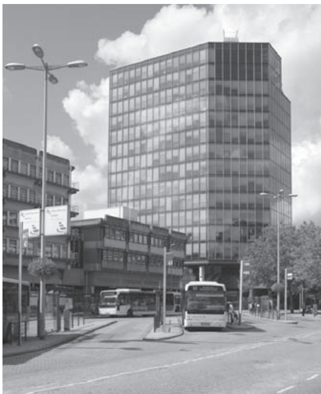
Afb. 3 Utrecht, Stationsplein met de gerenoveerde Catharijnetoren te Utrecht (foto auteur 2009)
