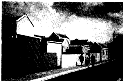
Afb. 6. Willemstad, Otrobanda: Restauratie kleine binnenstadswoningen Stichting Monumentenzorg (foto: C.L.T.G. 1986).
