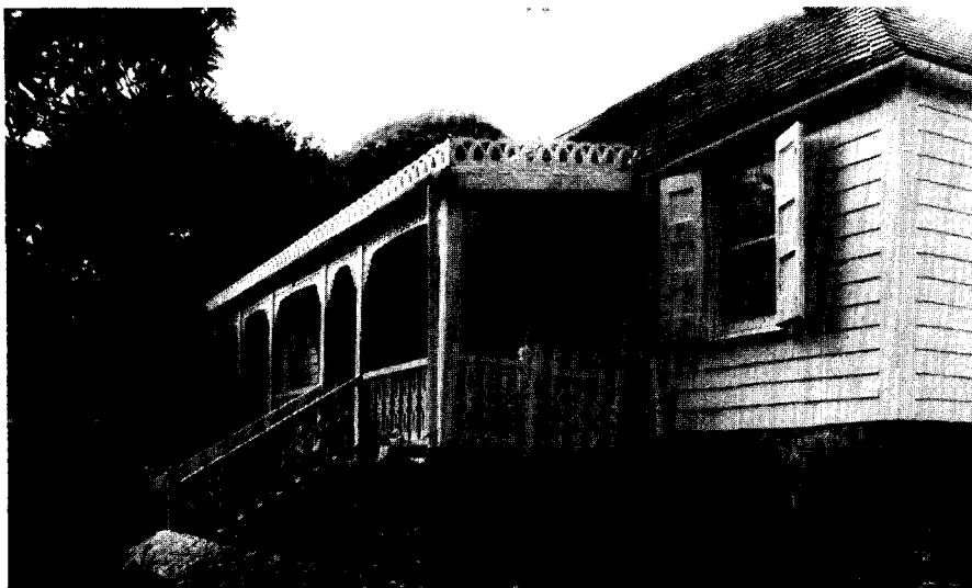
Afb. 9. Saba, Windwardside. Fraai huis, na periode van verwaarlozing nu weer in gebruik (foto: C.L.T.G. 1989).
