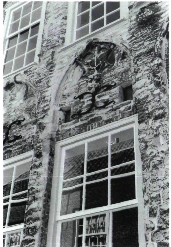
Afb. 10. loodvullingen t.p.v. oorspronkelijke vensteropeningen, foto J. Weyts.
