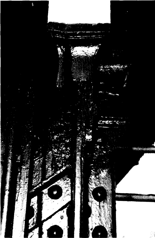
Afb. 11. De kapitelen zijn door roestvorming van de onderliggende staalconstructie stukgedrukt. (Foto Holland Railconsult, Utrecht)
