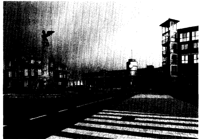
Afb. 9. Het stationsgebouw van 1996 van Holland Railconsult (architect R.M.J.A. Steenhuis). (Foto Frank van Dam, Utrecht)
