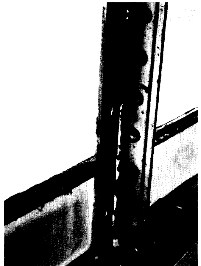
Afb. 12. Aan de westzijde van de hoge kappen is de bevestiging van de gietijzeren raamelementen grotendeels verdwenen of sterk door roest aangetast. (Foto Holland Railconsult, Utrecht)
