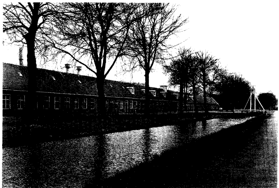
4. Veenhuizen II (1823) gelegen aan de Oude Gracht, dateert uit de tijd van Johannes van den Bosch en is het enige behouden gebleven gesticht uit de beginperiode van de Maatschappij van Weldadigheid. Opname: Rijksdienst voor de Monumentenzorg, Zeist, door A.J. van der Wal, 1992.
