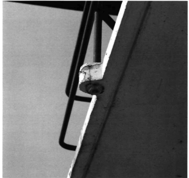
Afb. 8. Maastricht, seinhuis Post T, bevestiging van de balustrade, vóór de restauratie. (Rijksdienst voor de Monumentenzorg (maart 2003), Zeist. Fotografie: G.J. Dukker)
