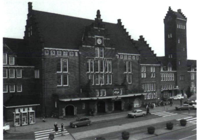
Afb. 3. Maastricht, station van de Nederlandse Spoorwegen. Architect: G.W. van Heukelom, 1914-1915. (Rijksdienst voor de Monumentenzorg, Zeist (september 1975). Fotograaf: L. Tangel).
