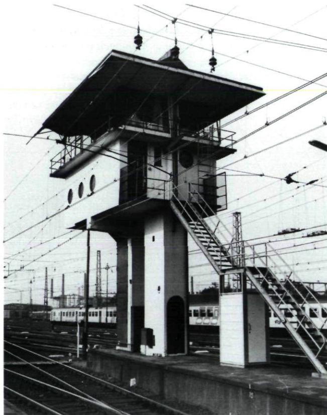
Afb. 1. Maastricht, seinhuis Post T. De foto is gemaakt tijdens de voorbereidingen van de aanwijzing tot beschermd monument. (Rijksdienst voor de Monumentenzorg, Zeist september 1981)
