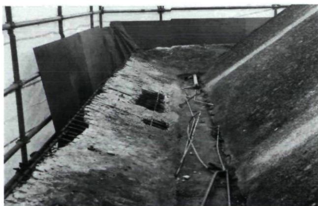
Afb. 14. Maastricht, seinhuis Post T, restauratie van het dak. De wapening van het beton ligt bloot. (Nederlandse Spoorwegen zomer 2003)
