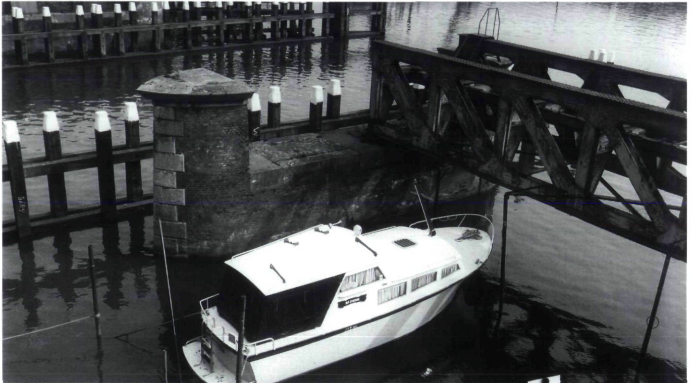
Afb. 8. Geertruidenberg, onderdeel van de voormalige spoorbrug in de Langstraatspoorlijn over de Donge. Foto L. Tangel, RDMZ, september 1988.
