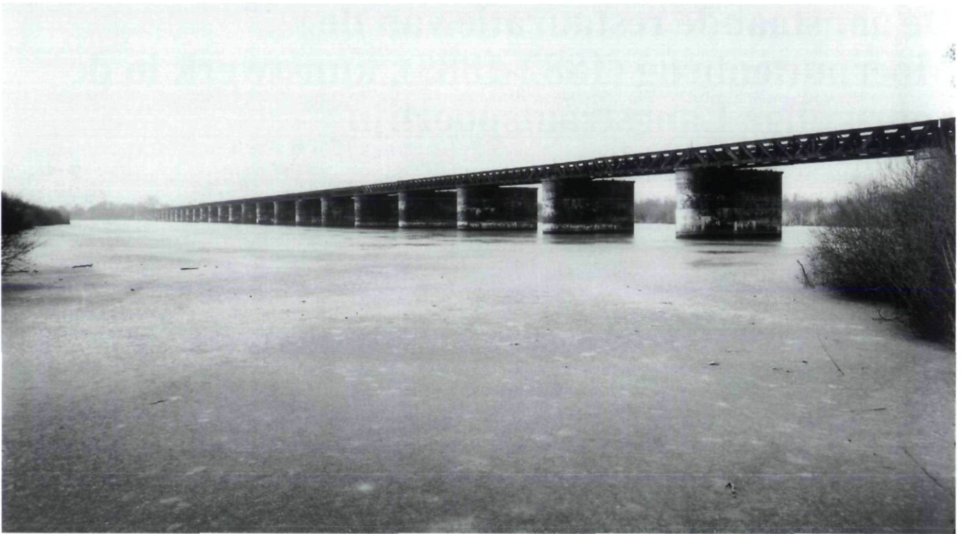
Afb. 2. Ten zuidwesten van 's-Hertogenbosch ligt in het voormalige Bossche Inundatieveld de Moerputtenbrug. Foto P. van Galen, RDMZ, december 1995.
