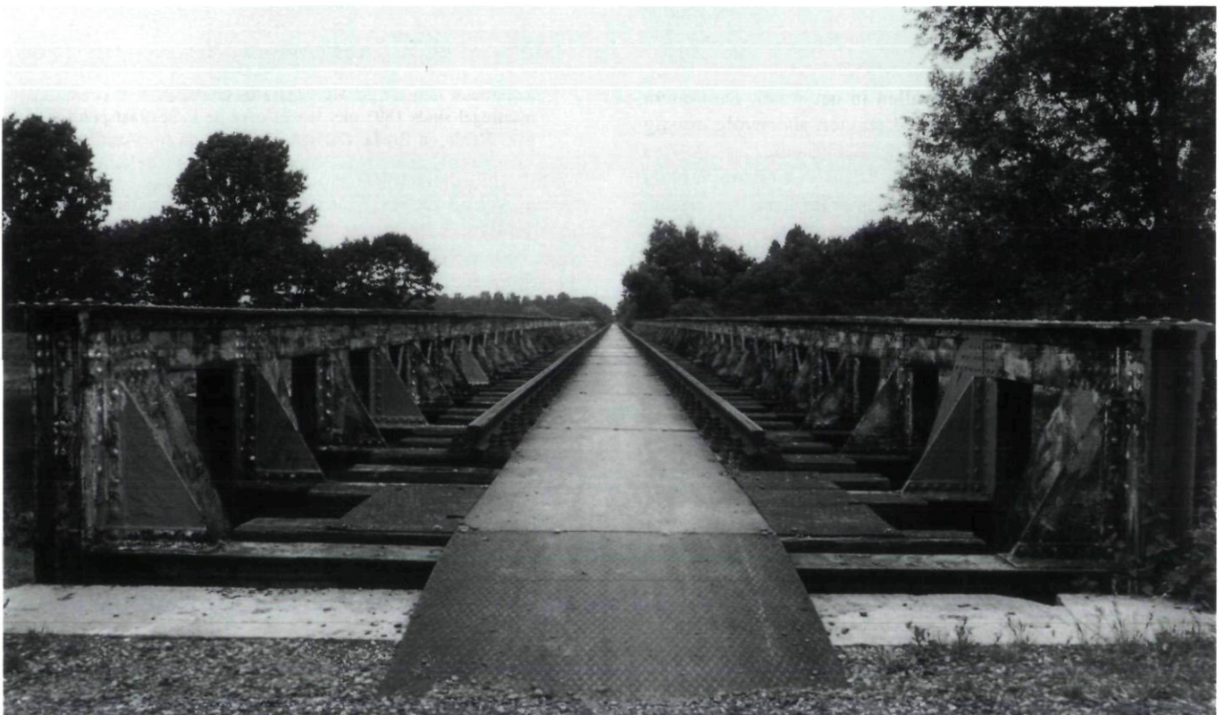
Afb. 11. Waalwijk, voormalige spoorbrug in de Langstraatspoorlijn, gezien naar het oosten. Foto L. Tangel, RDMZ, augustus 1988.
