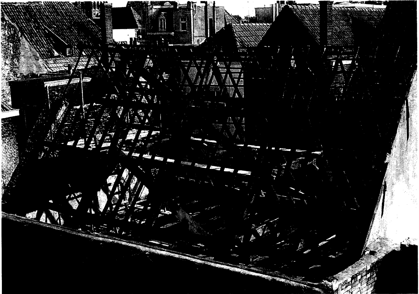
Afb. 7. Gezicht op een laat-middeleeuwse kap in een huis in de Visstraat, 's-Hertogenbosch (Visstraat 17). Dia: Afdeling Bouwhistorie Gemeente 's-Hertogenbosch
