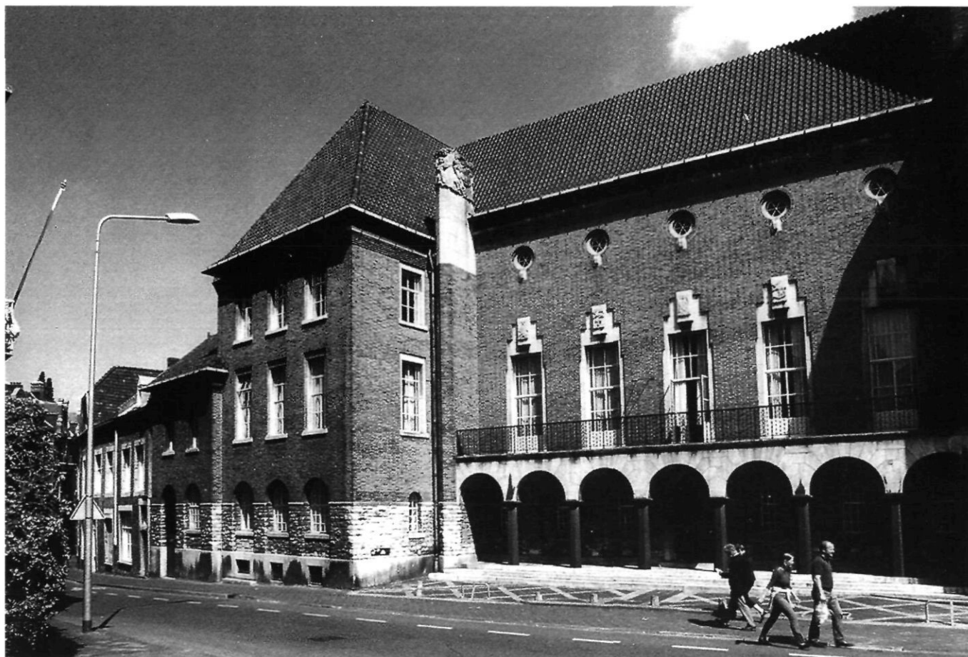
Afb. 1. Gevel van het Gouvernementsgebouw aan de Bouillonstraat, ingang van toenmalige Gouverneurswoning en representatief gedeelte (foto auteur, 2003)
