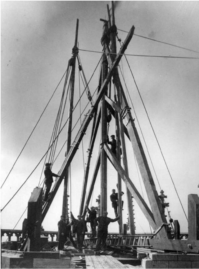
Afb. 6. Het plaatsen van de nieuwe kap op de Domtoren, rond 1910 (Het Utrechts Archief, collectie beeldmateriaal, catalogusnummer 24674)
