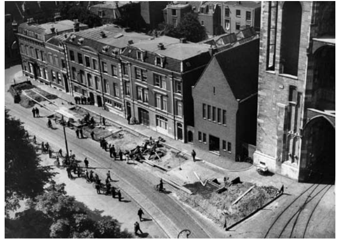
Afb. 15. Gezicht op de Domtoren en ontvangstgebouw. Tot 1936 liep tramlijn 2 onder de toren door en op het Domplein is men bezig met archeologische opgravingen. Rond 1933 (Het Utrechts Archief, collectie beeldmateriaal, catalogusnummer 97312)
