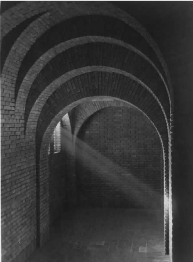
Afb. 12. Het interieur van het ontvangstgebouw, rond 1929 (Het Utrechts Archief, collectie beeldmateriaal, catalogusnummer 3205)
