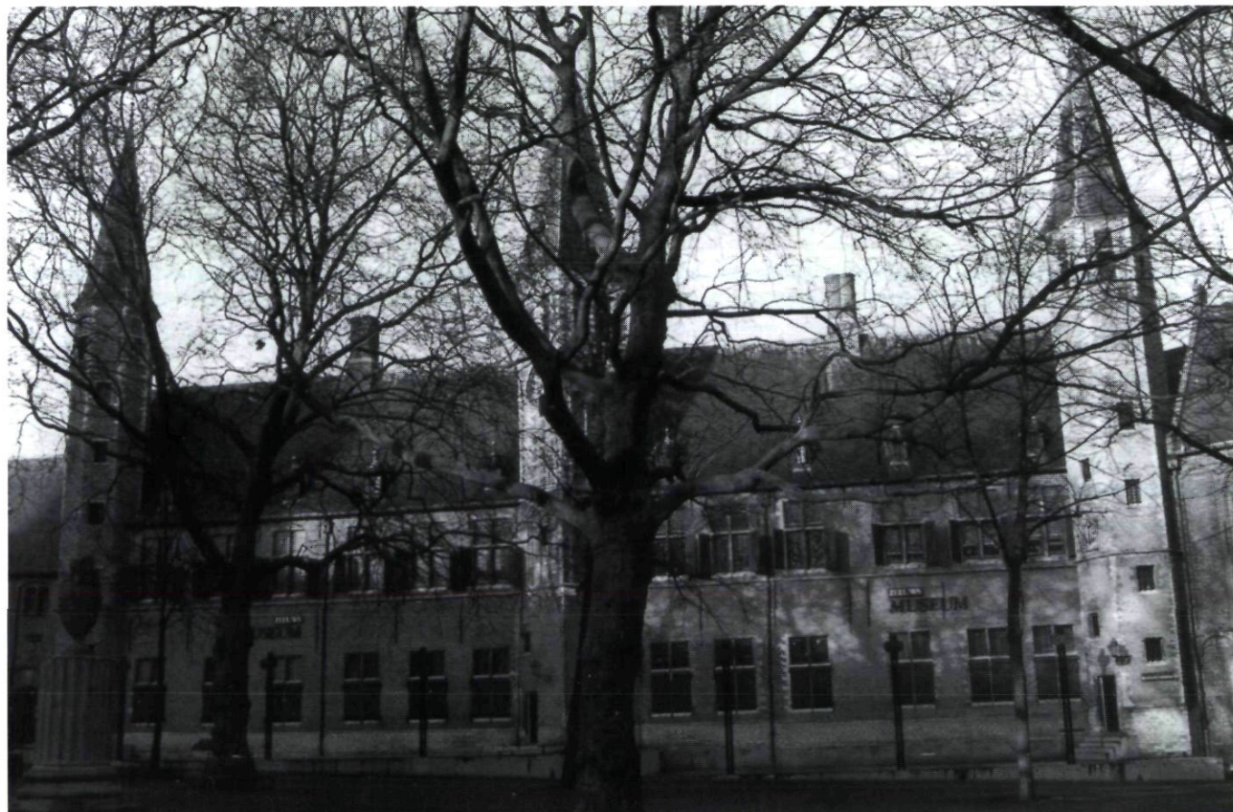
Afb.12. Gevel aan de noordzijde van het plein, huidige situatie. (Foto R. Visser)
