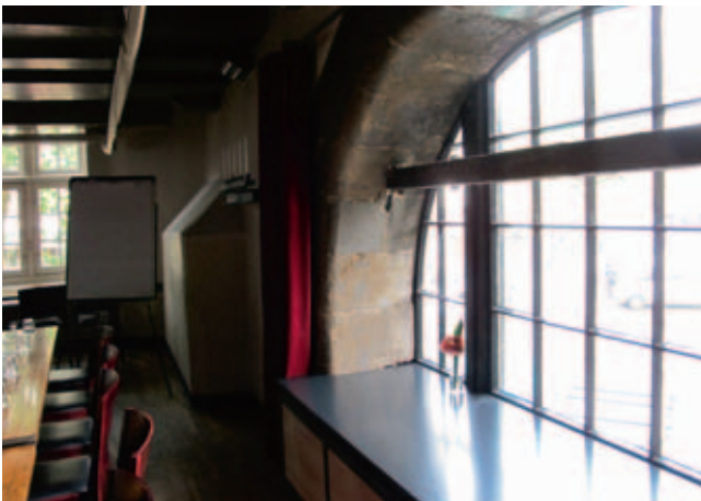
Afb. 4. Bewerkte foto van de verjonging aan de binnenzijde van de gevel richting de Geldersekaade, genomen op het mezzanine niveau richting het noorden (foto en bewerking auteur)
