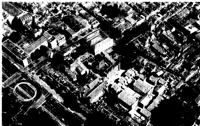
Afb. 4. Het nieuwbouwcomplex Mariaplaats-Walsteeg, tussen de gebouwen van het Conservatorium (midden boven) en de tuin van het Duitse Huis (rechtsonder). Door dat het ontwerp geënt is op de middeleeuwse verkaveling en de in de loop der eeuwen gegroeide bouwmassa's, past het organisch in het historisch stadsbeeld. (Dia: A.F.E. Kipp)
