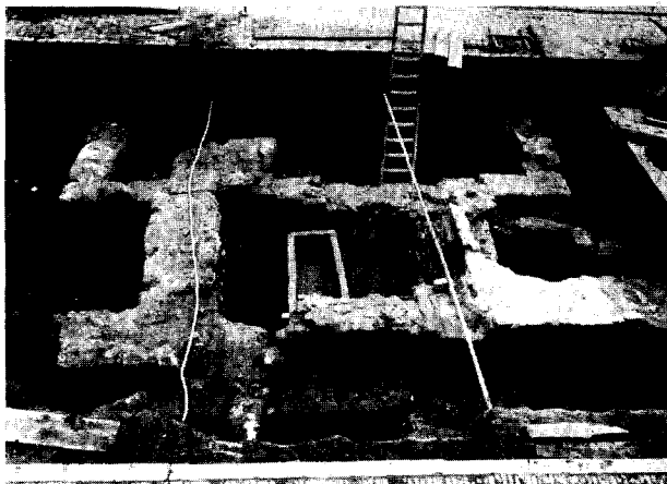
Afb. 11. De opgraving van 1933; het muurwerk ten westen van de Heilige Kruiskapel, gezien naar het oosten. Achteraan is de westzijde van het schip van de kapel zichtbaar (afb. 10, a). Daarvoor ligt de roodzandstenen sarcofaag. Op de voorgrond zien we het jongere muurwerk (afb. 10, b) en, gedeeltelijk, de oudere muur (afb. 10, c). Vooral bij de linker aansluiting van het jongere muurwerk op de westmuur van de kapel is goed te zien dat het een latere aanbouw betreft (z.g. koude naad)
